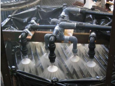
Ekipman temizleme Cleaning
